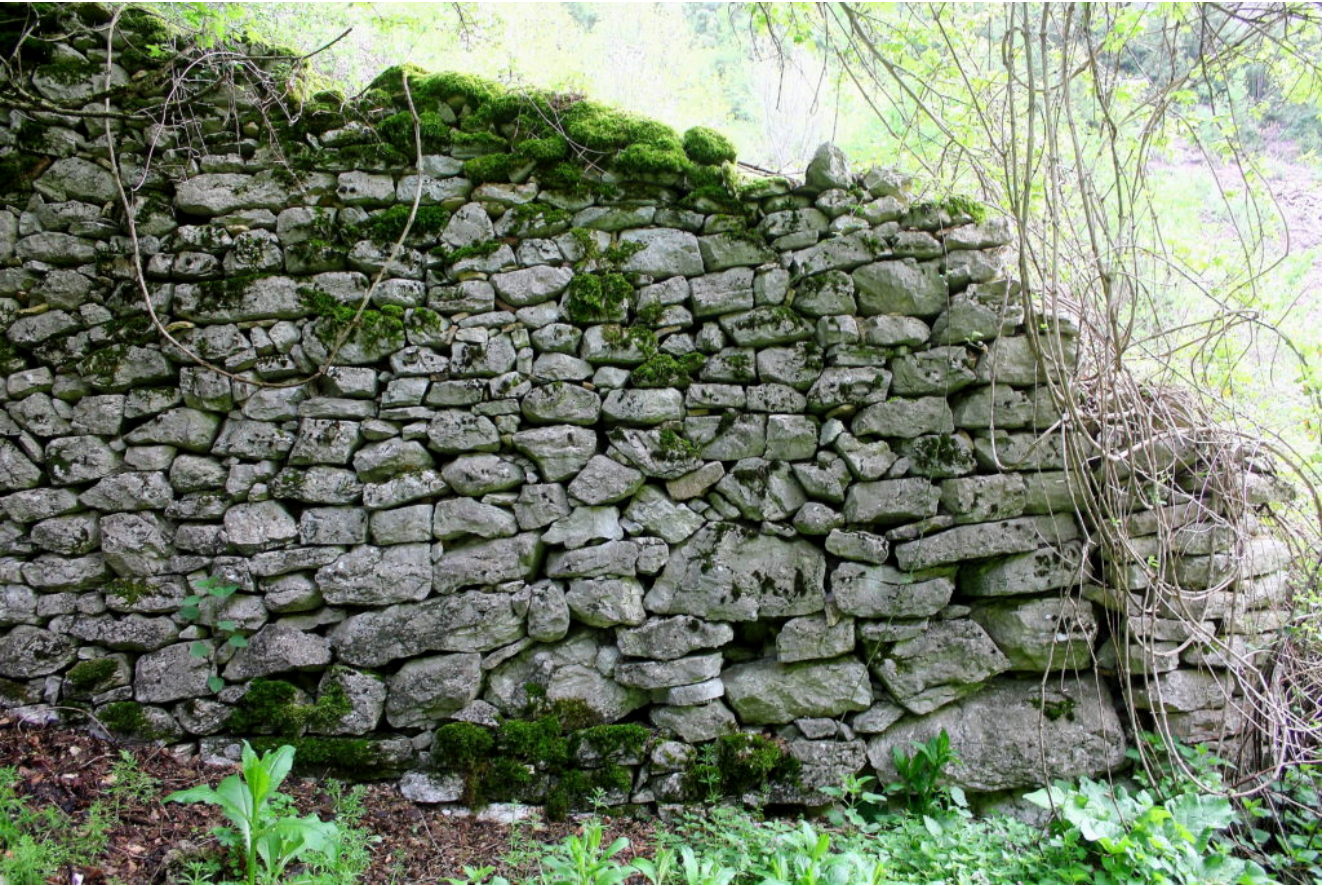
24- La perfetta esecuzione del muretto a secco fatta da un abile maestro ha fatto sì che stia in piedi da secoli.
