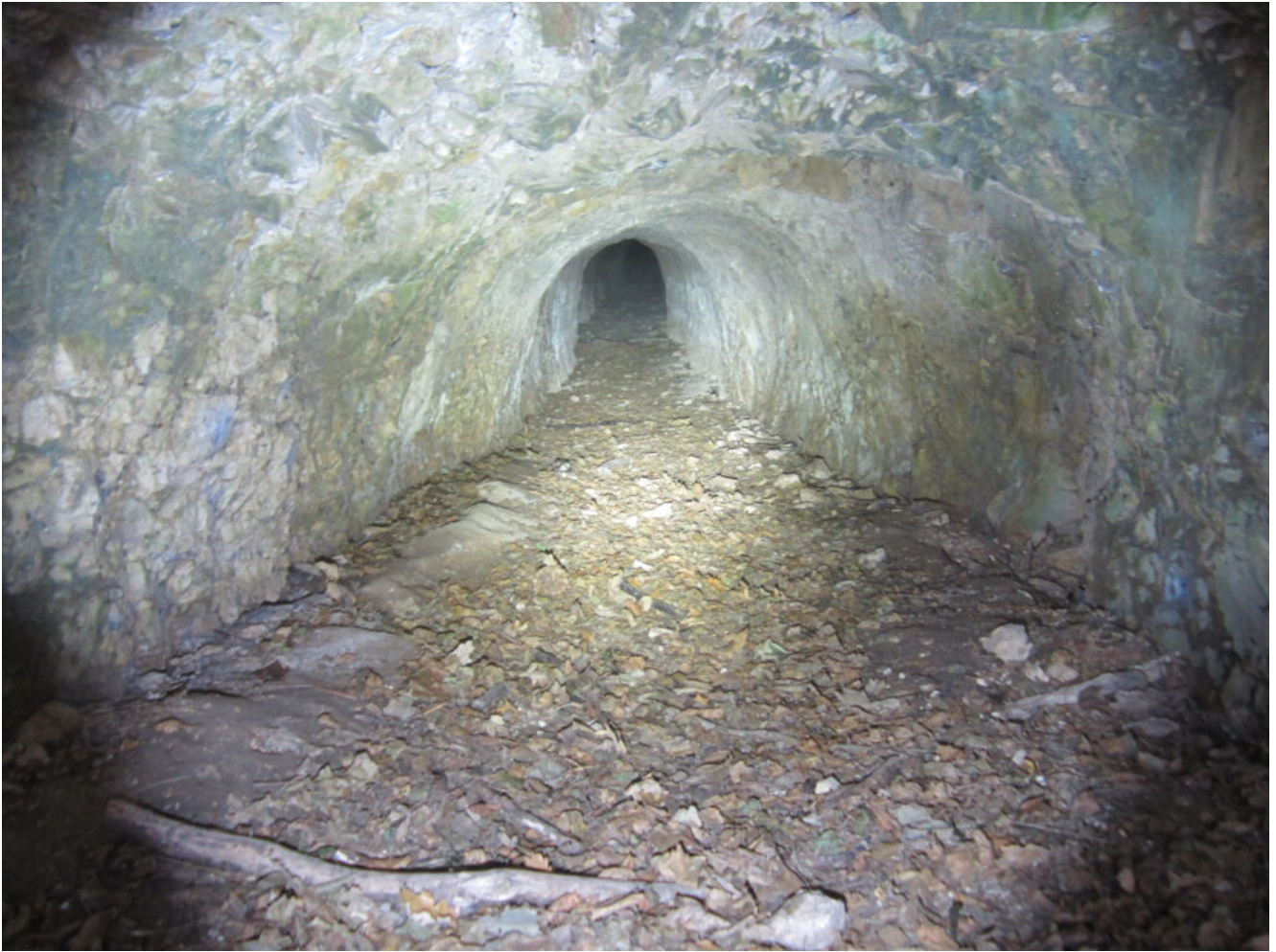
27 – 29- La galleria più profonda presente di fianco alla strada nella curva superiore
