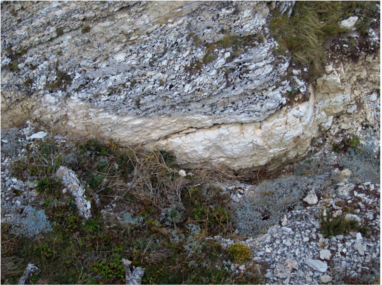
12- Particolare della foto n.11 dove si nota l'abbassamento del livello del terreno di circa 50 centimetri.
