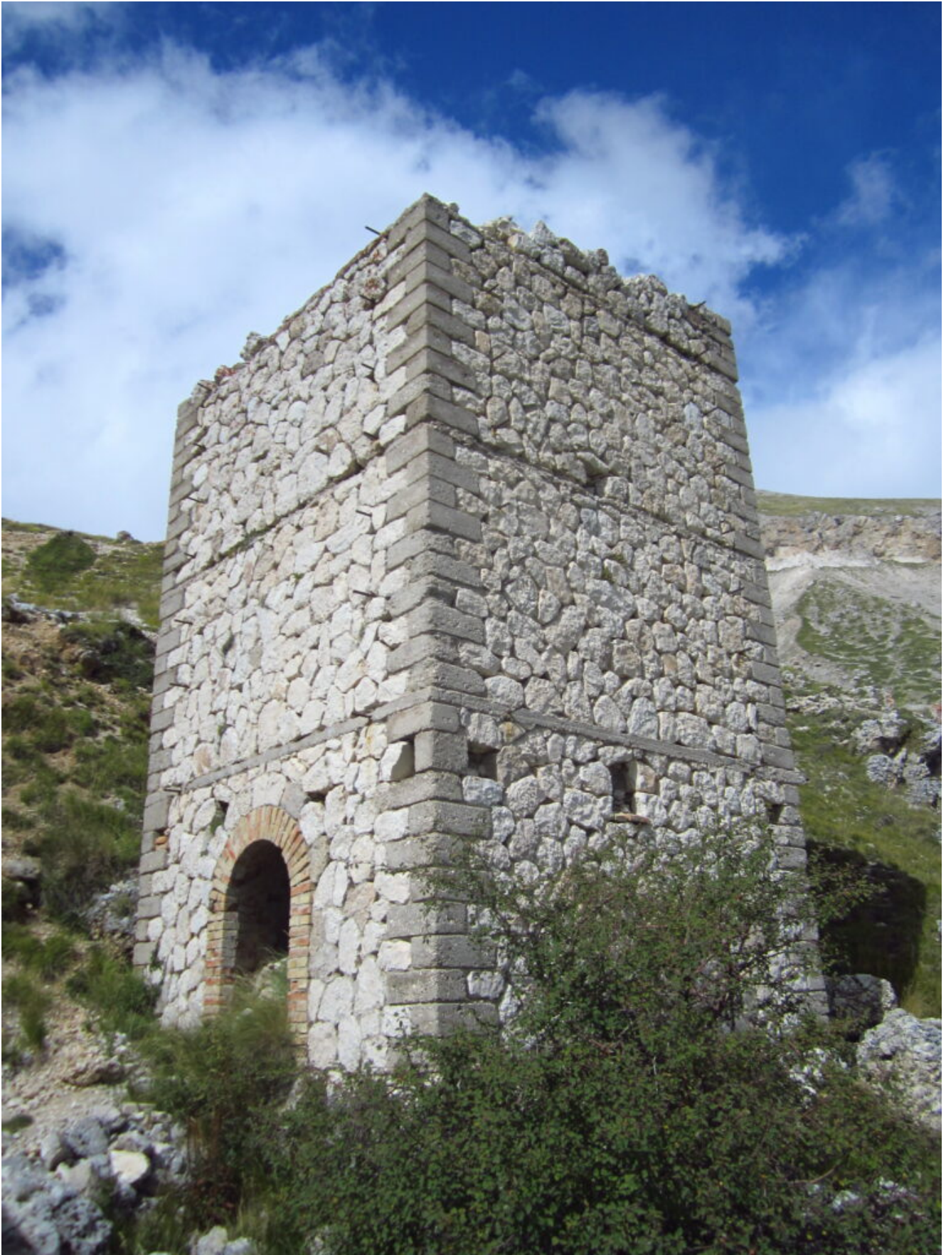
17- Il pozzo di accesso alla Miniera.
