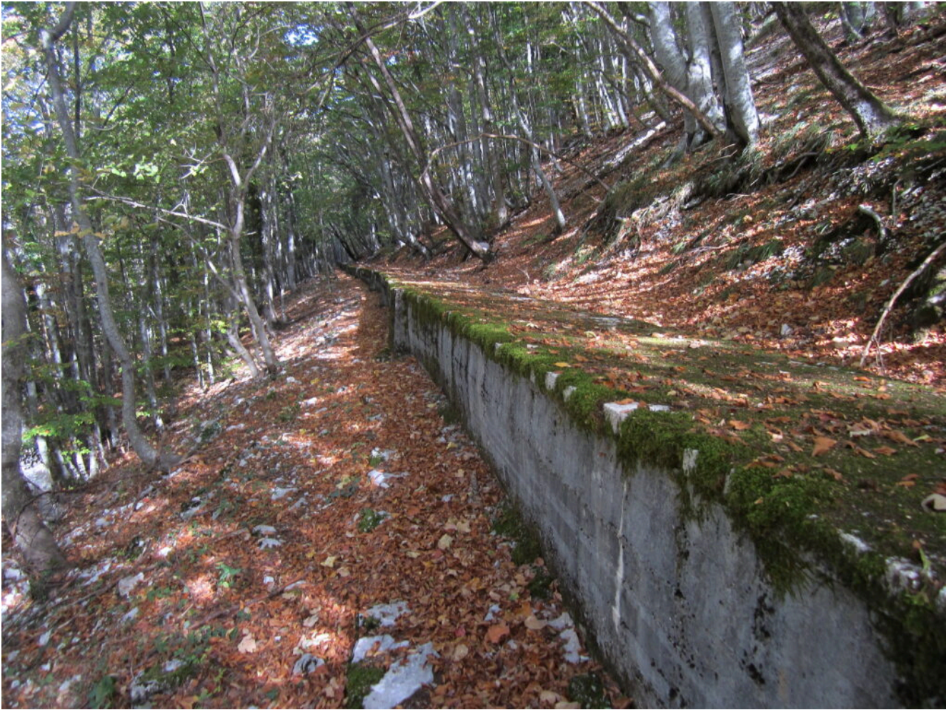
4- Il tratto con il canale in cemento
