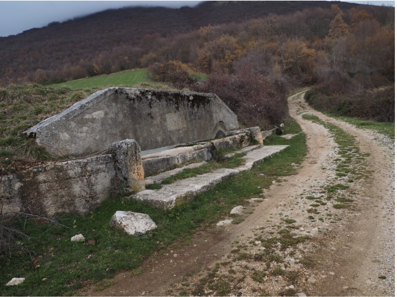
1- La fonte presente all'imbocco del tratturo
