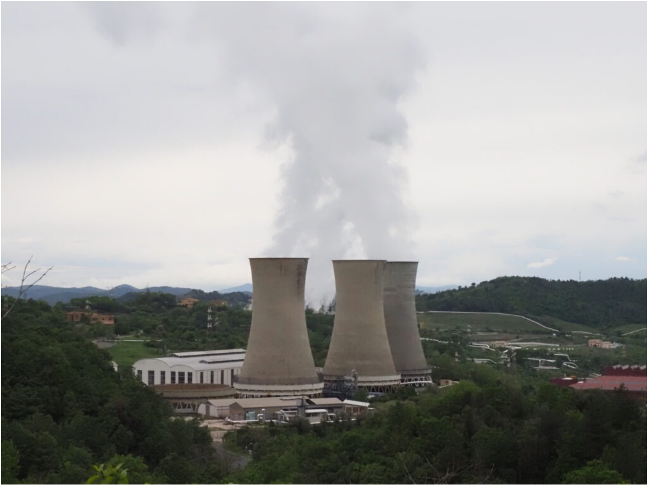
1- Le grandi torri di raffreddamento di una delle tante centrali elettriche geotermiche dei dintorni di Larderello.
