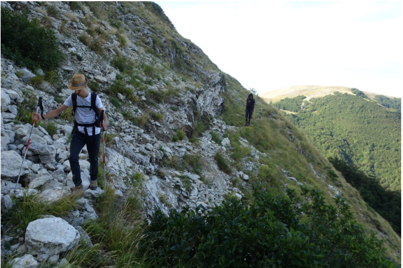
11- Il tratto degradato e franato dal sisma del 2016 oltre lo Scoglio della Volpe.
