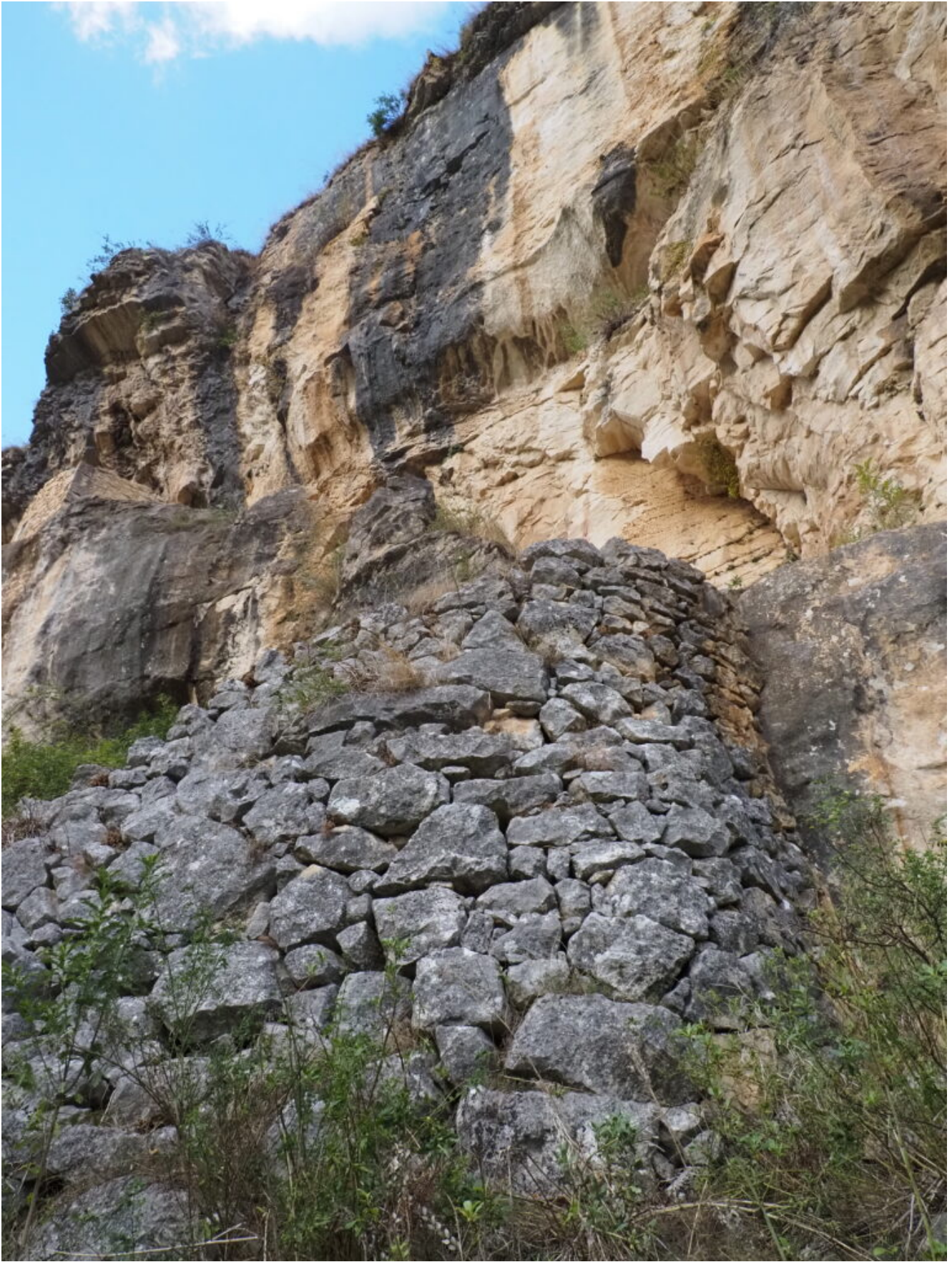
23- Il muro a secco che sorregge da secoli la scala di accesso al fosso sottostante l'Eremo.
