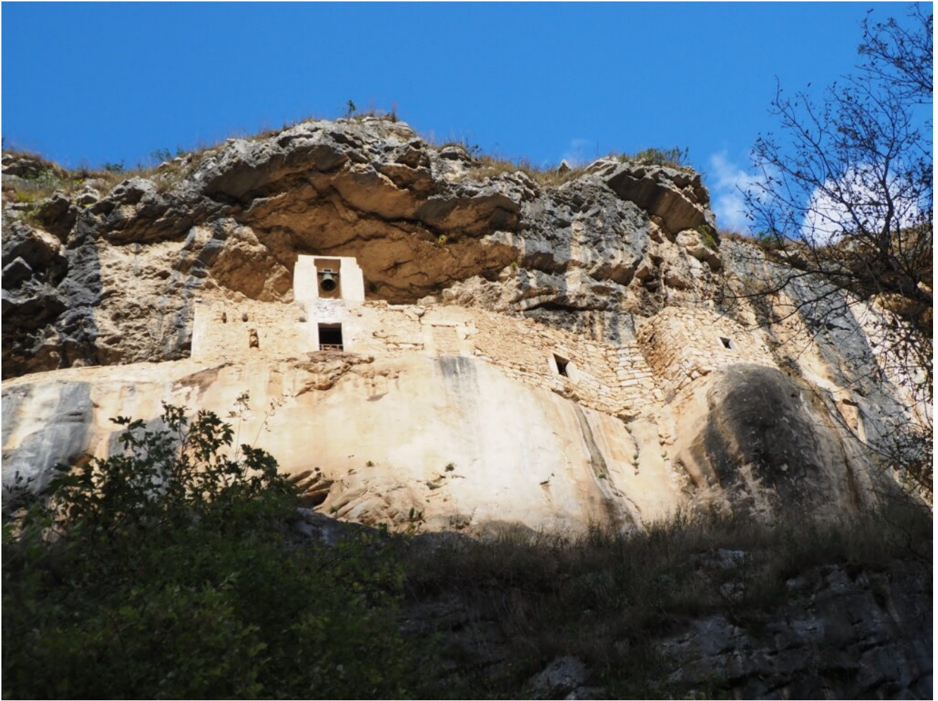
28 – 29 – L'eremo di San Bartolomeo in Legio visto dal Vallone sottostante.
