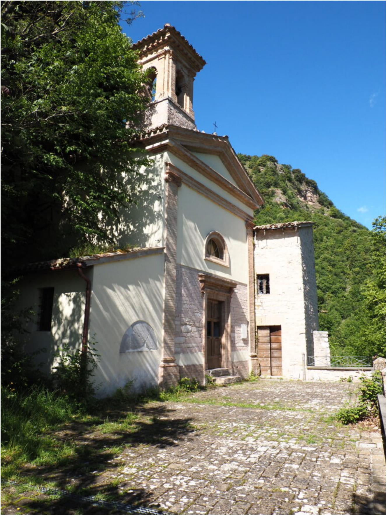
7 – L'Eremo di Sant'Angelo in Prefoglio, con porte aperte e finestre rotte ed assenza di segnaletica di divieto o pericolo.
