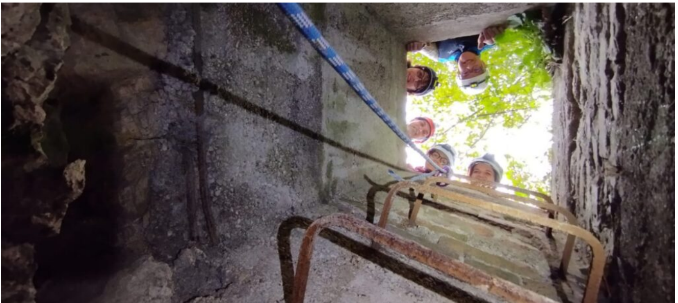
39 – 40 – Il pozzo di ingresso
