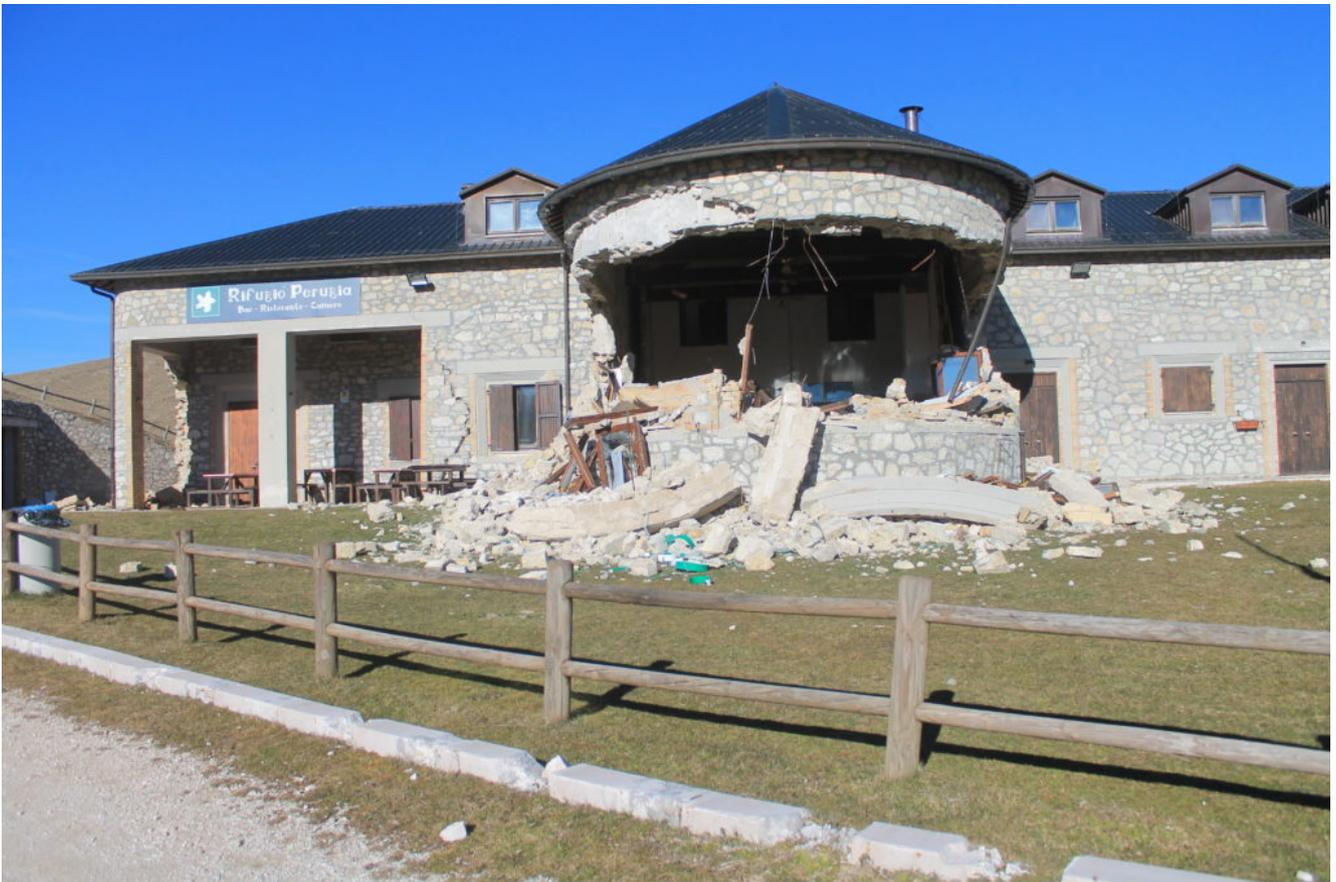
9- Il Rifugio Perugia, l'evidente errore costruttivo di un pesante cordolo in cemento armato sopra un muro di pietre non
