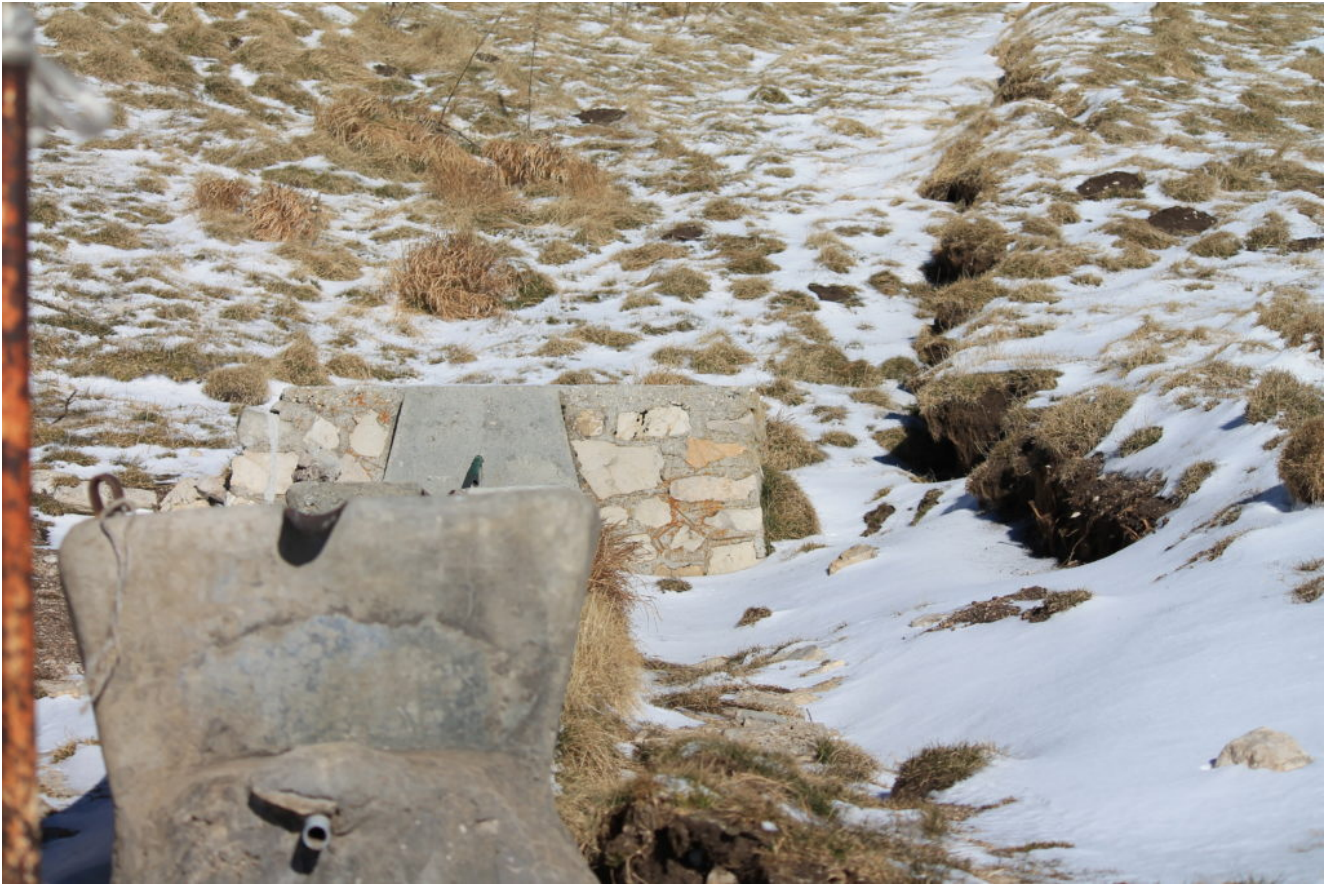
28- La fontana sottostante la Croce di Zilioli spostata dalla fenditura che le passa di lato.
