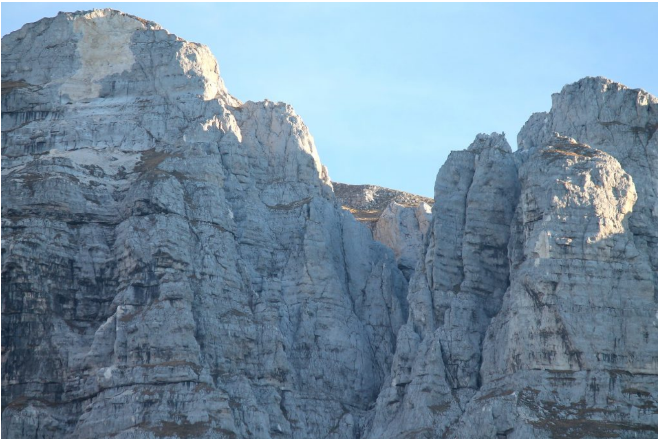
11- A sinistra la cima dello Spalto Centrale con la grande frana e a destra lo Spalto Occidentale, nella parete Nord del
