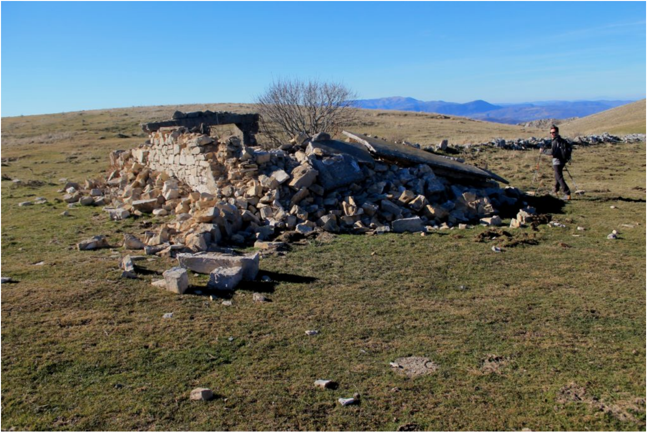
8- Il Casaletto Onori distrutto dal sisma.
