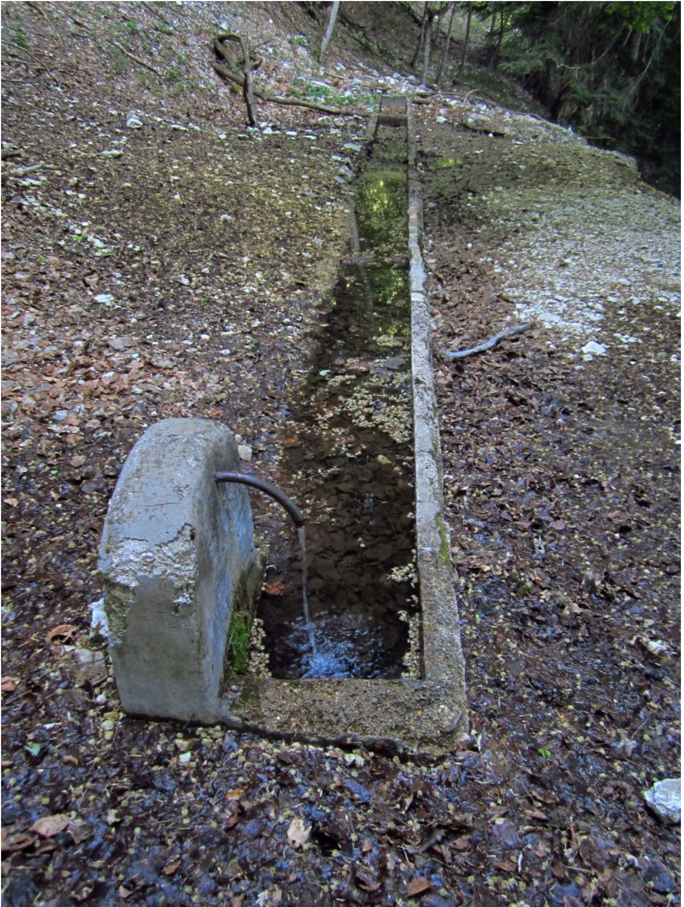
7- La Fonte Efre parzialmente ricoperta dai detriti cumulati dalle slavine invernali.
