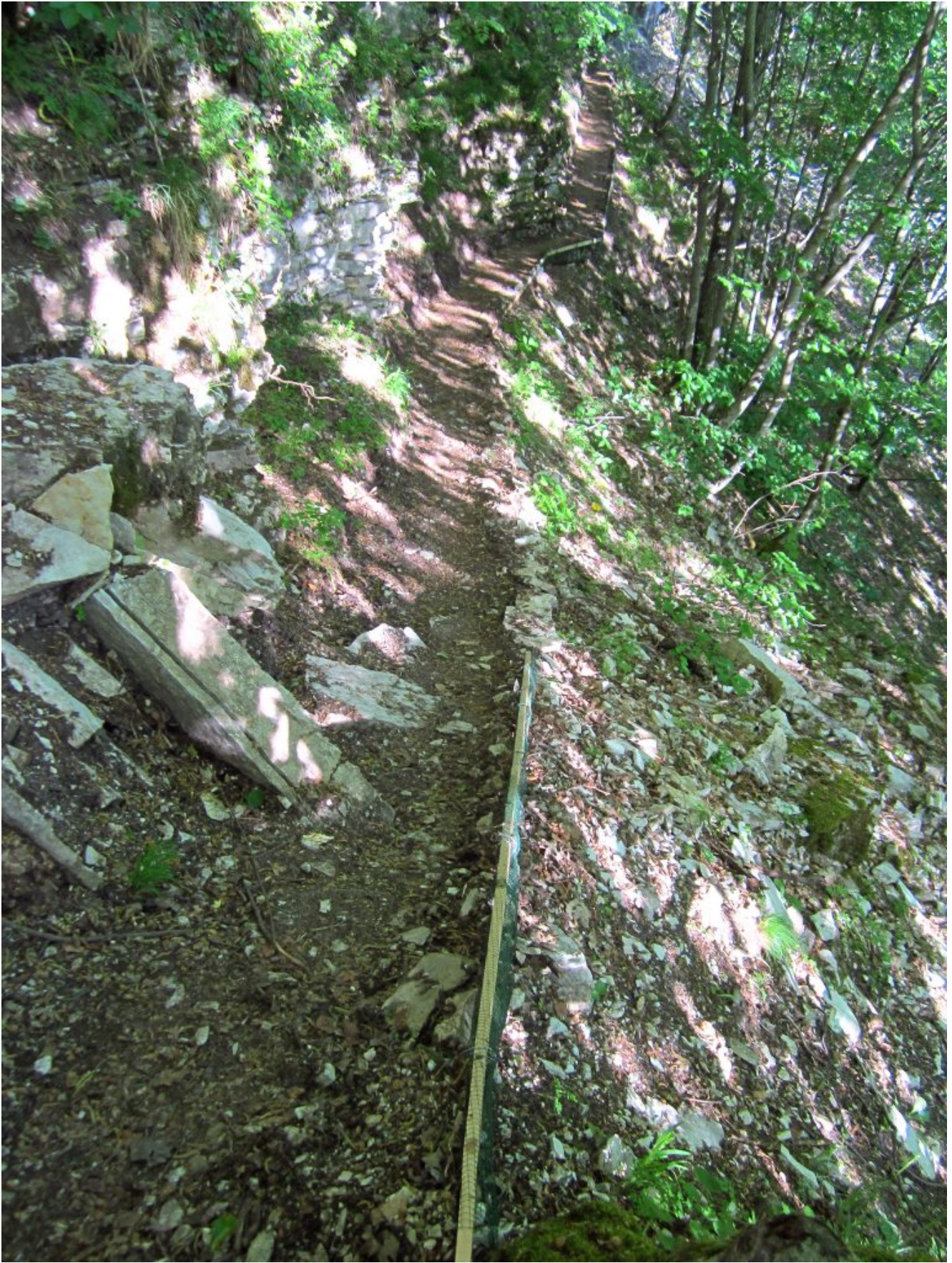
2- Opere di contenimento nel sentiero Bolognola-Cascate dell'Acquasanta realizzate con una semplice tavola in un ripido pendio soggetto a slavine.
