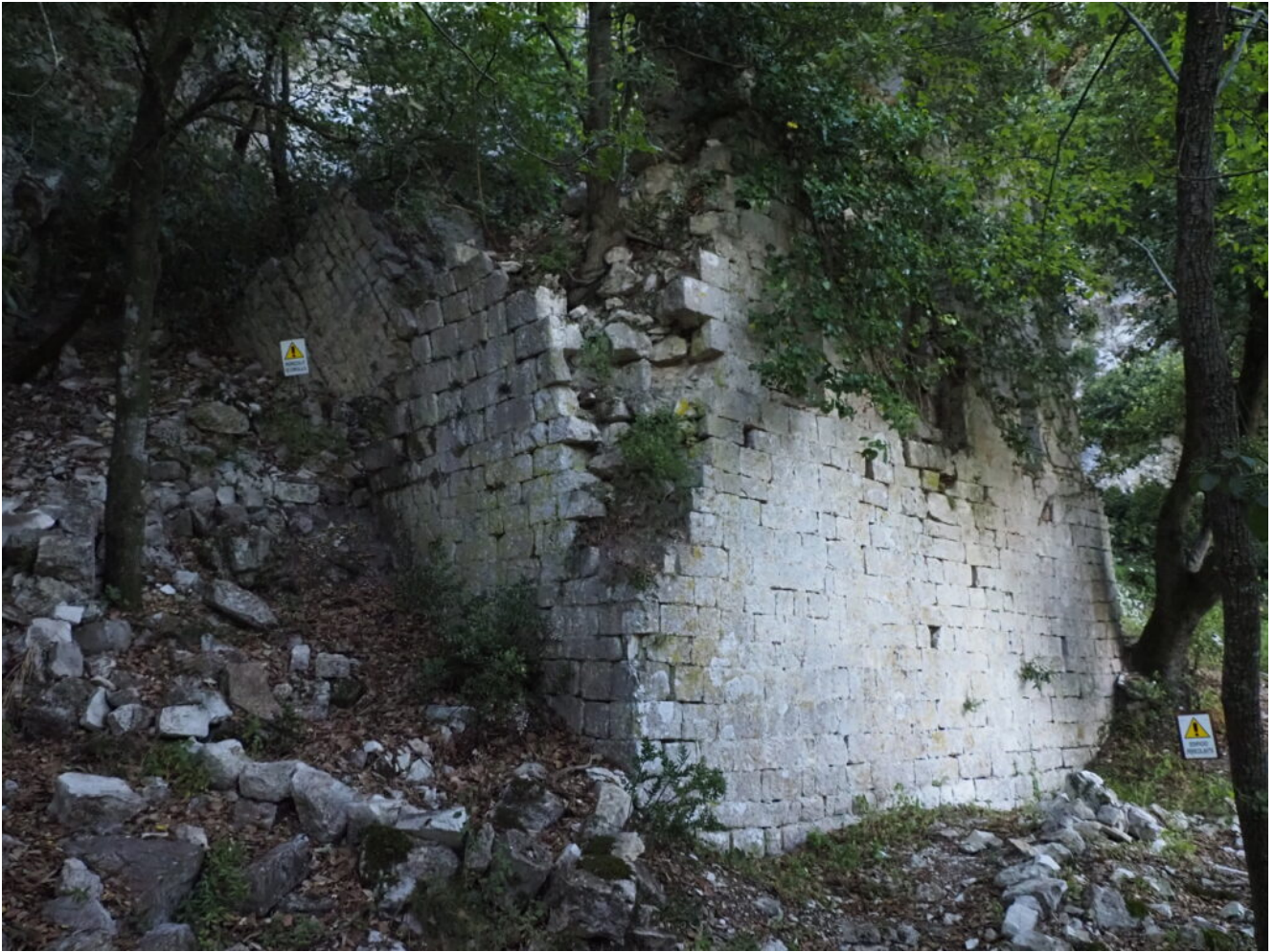
19 – 21 -I ruderi addossati alla parete rocciosa.
