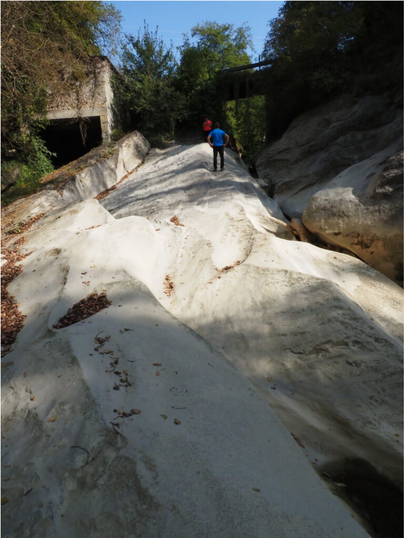
71- L'ex Mulino Brandi, ormai ridotto ad un vuoto edificio.
