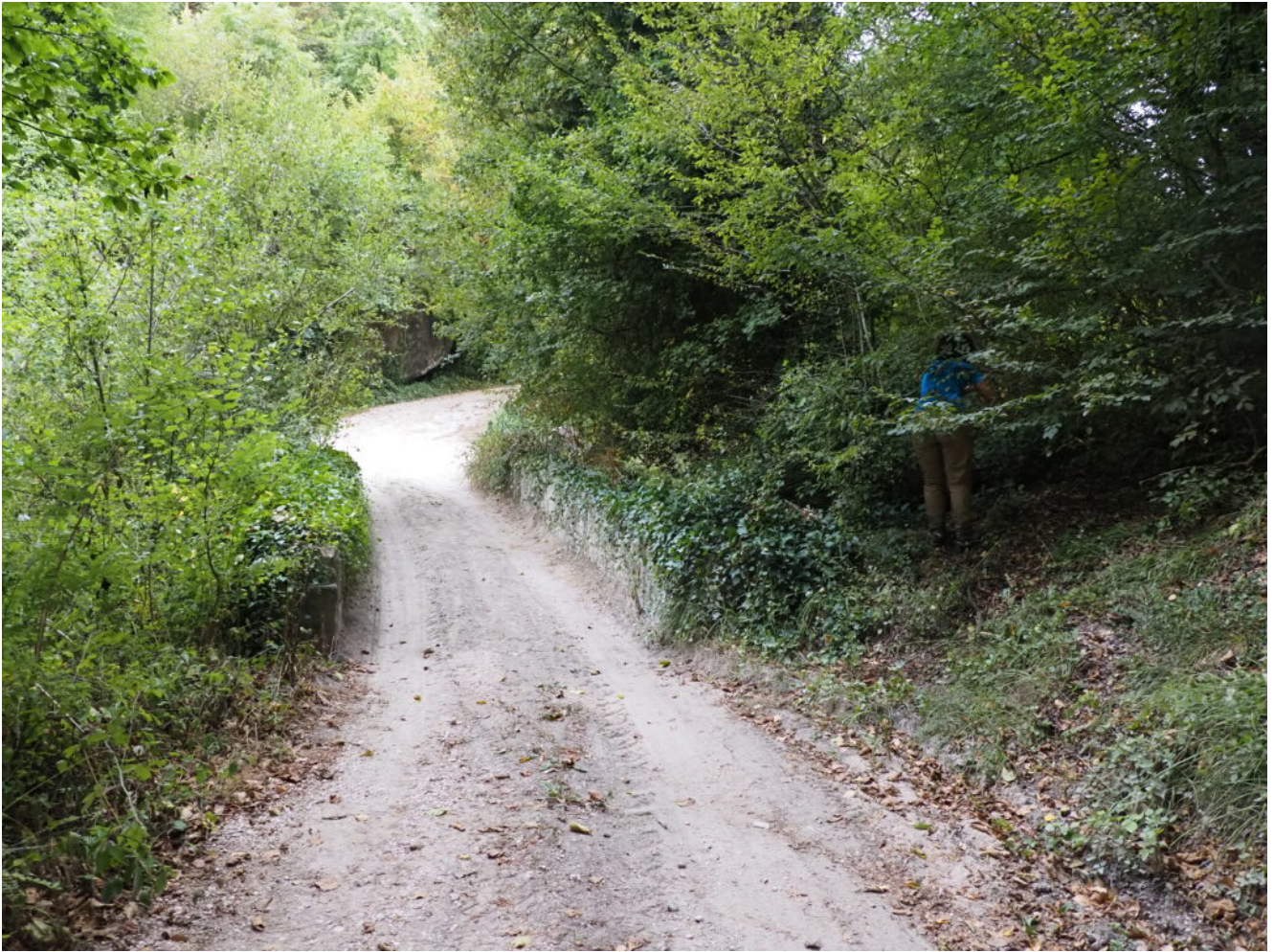
3- Il ponte Romano.
