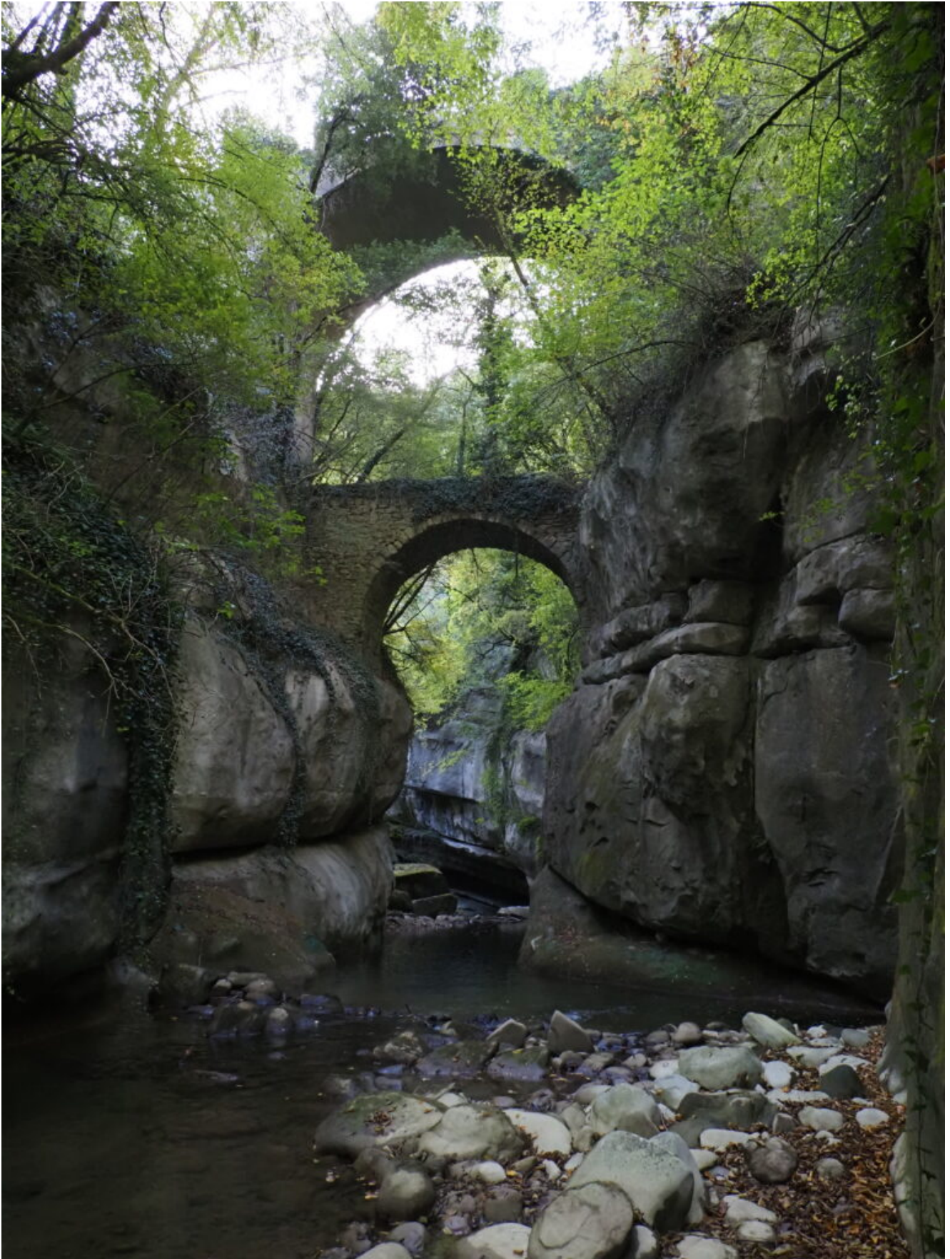
48 – 49 – Il ponte Romani inferiore ed il Ponte moderno sovrastante.
