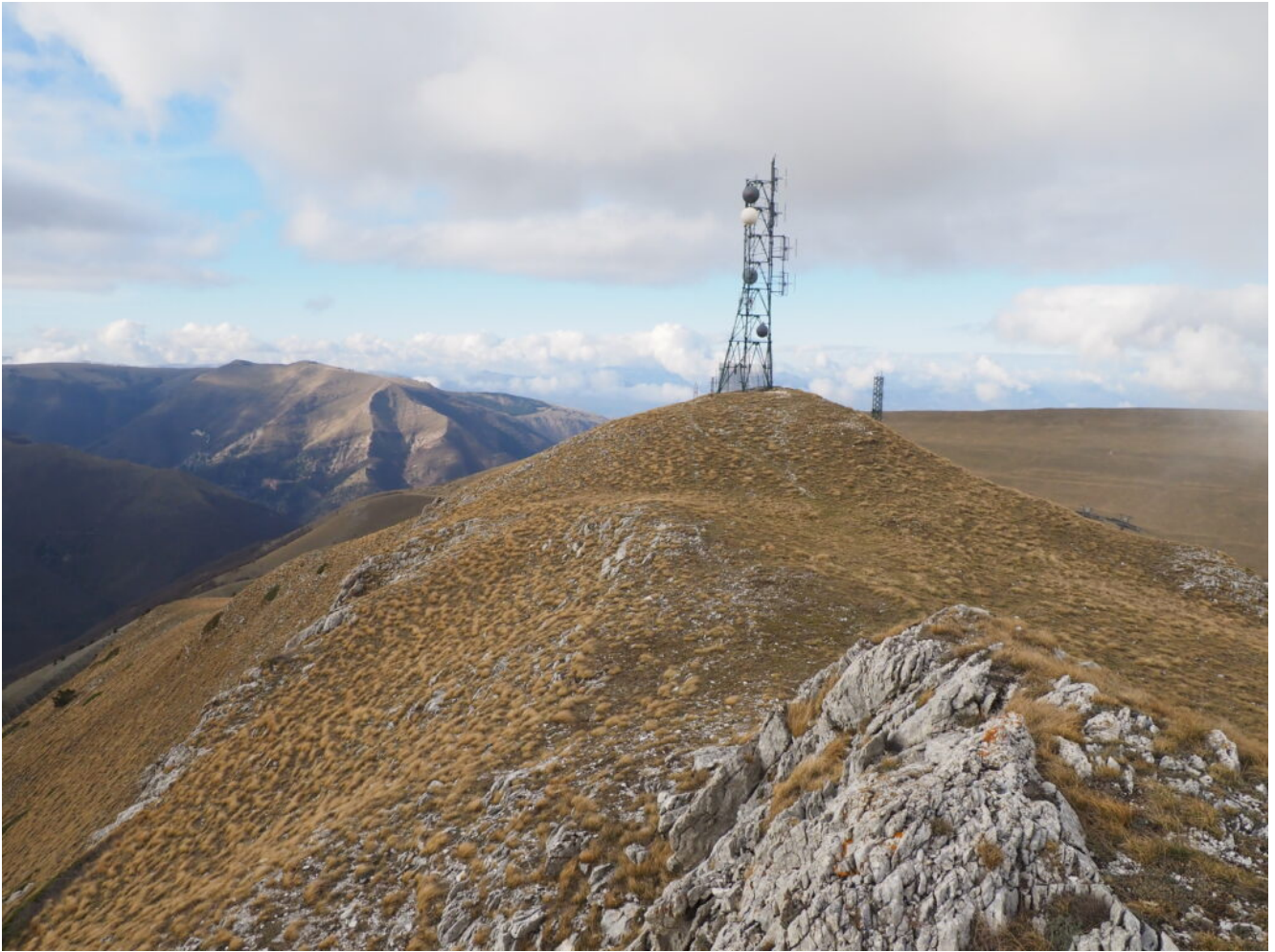
15- La cima del Monte Sassotetto con il grande Traliccio.
