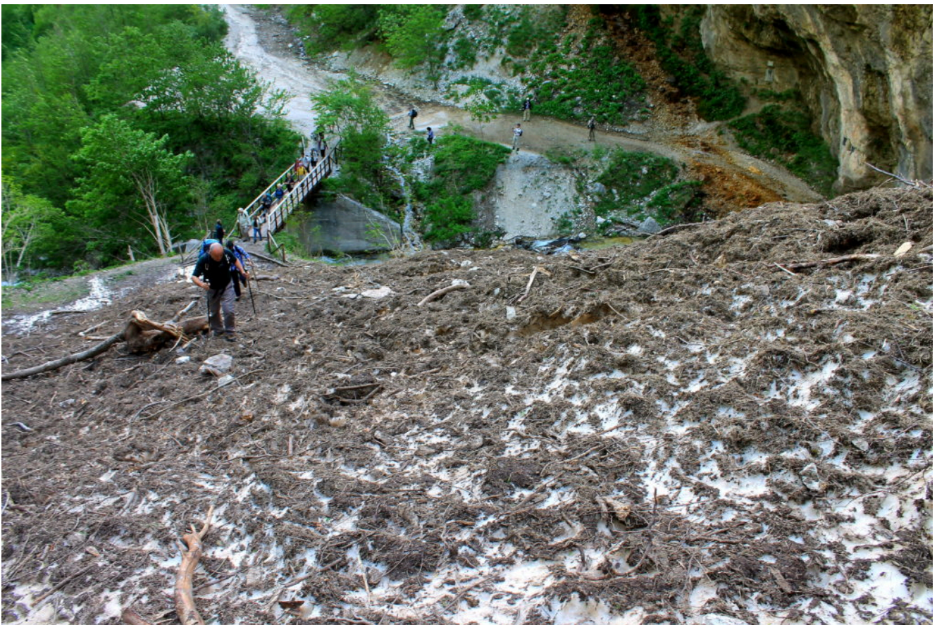
26- Le Pisciarelle, maggio 2015 c'era ancora il ponte.
