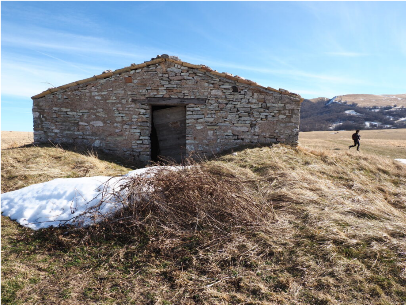
86- Veduta verso Est, a destra il Monte Monticoli.
