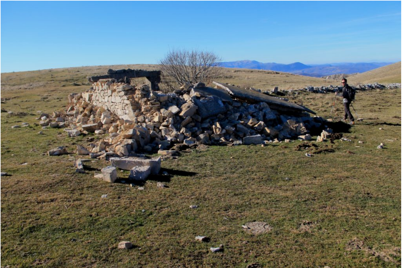
8- Il Casaletto Onori distrutto dal sisma.
