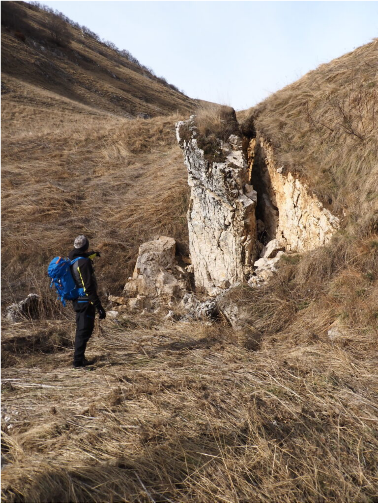
43- Un distacco dalla parete nei pressi dell'Inghiottitoio provocata dal terremoto del 2016.
