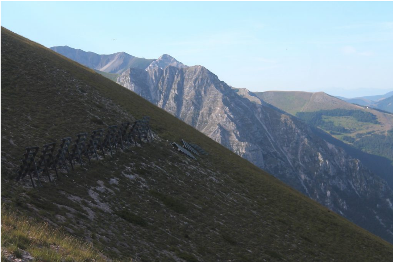
4- salita della cresta per la Croce di Monte Rotondo in corrispondenza delle barriere antivalanghe
