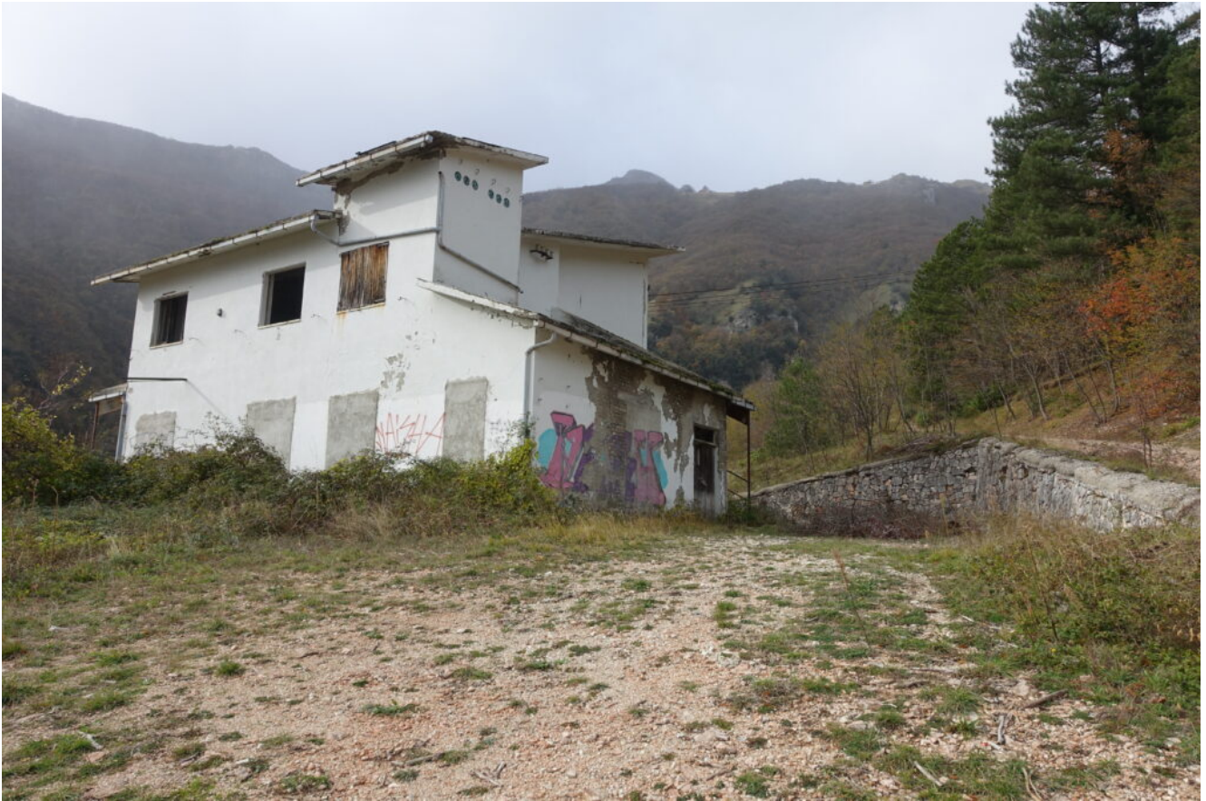
1- La vecchia funivia per Sassotetto, ormai ridotta ad un rudere.
