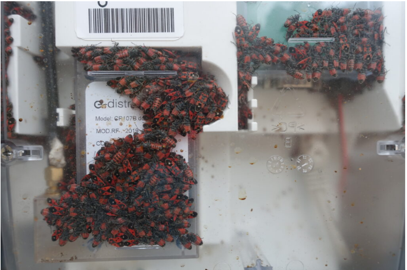
2- Nel tepore di un trasformatore di un quadro elettrico aperto posto in un palo nei pressi della stazione delle cimici
