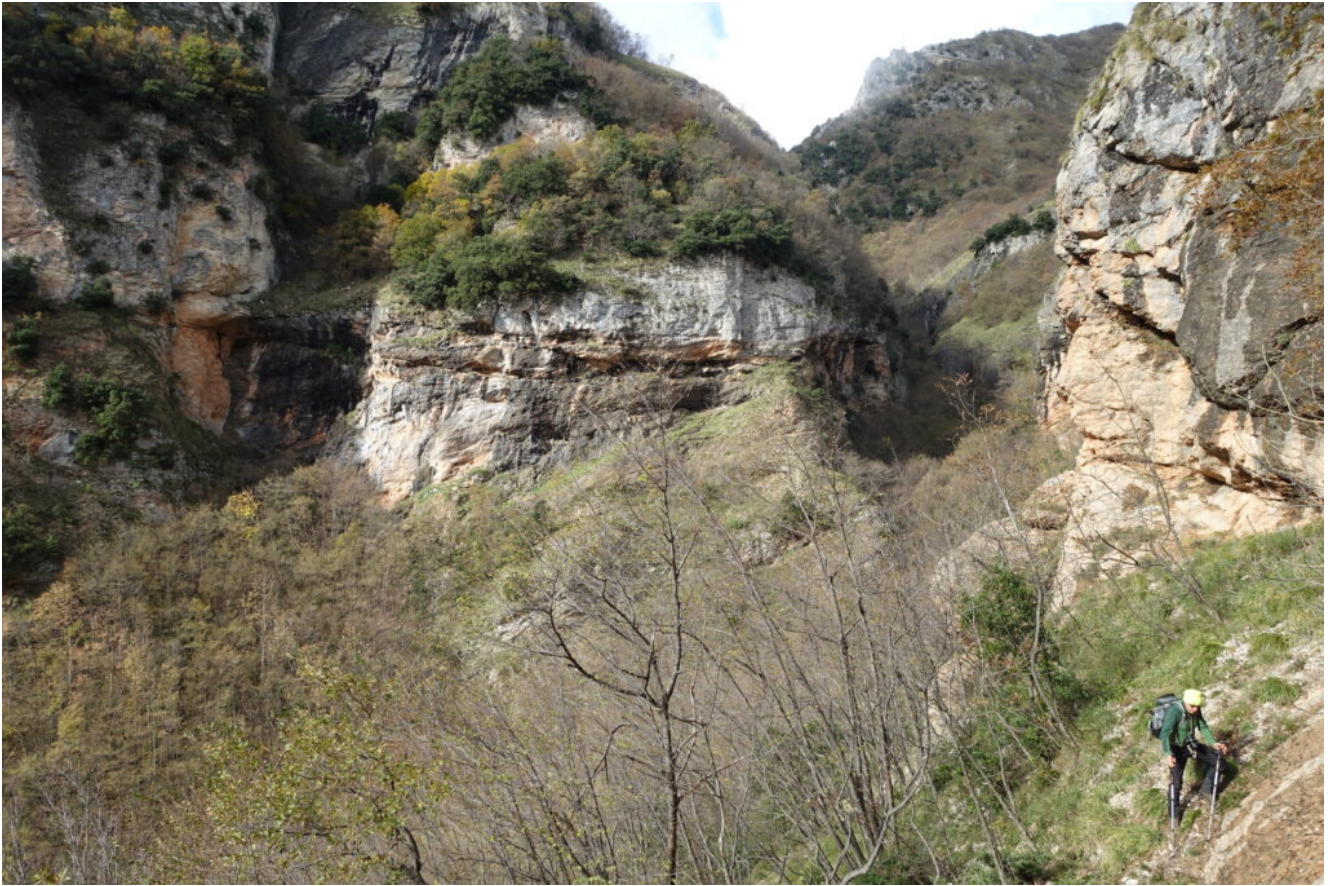
5- Il Fosso di Fonte Lardina, sopra allo scoglio in alto sullo sfondo a destra passa la strada per Sassotetto.
