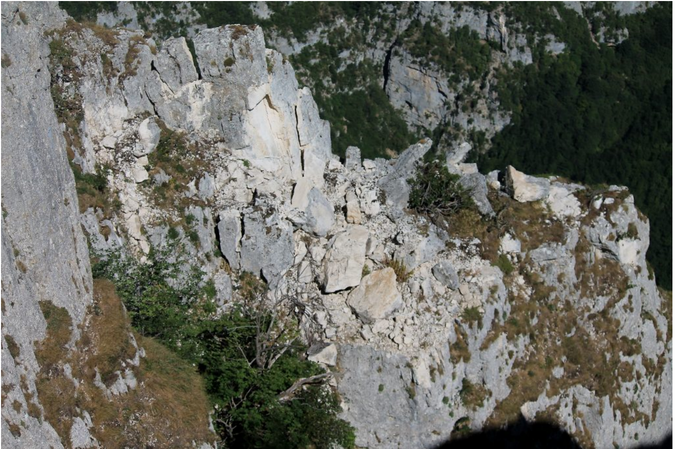
9- la prima cima del torrione, completamente distrutta dal terremoto e con grandi massi ancora in bilico.
