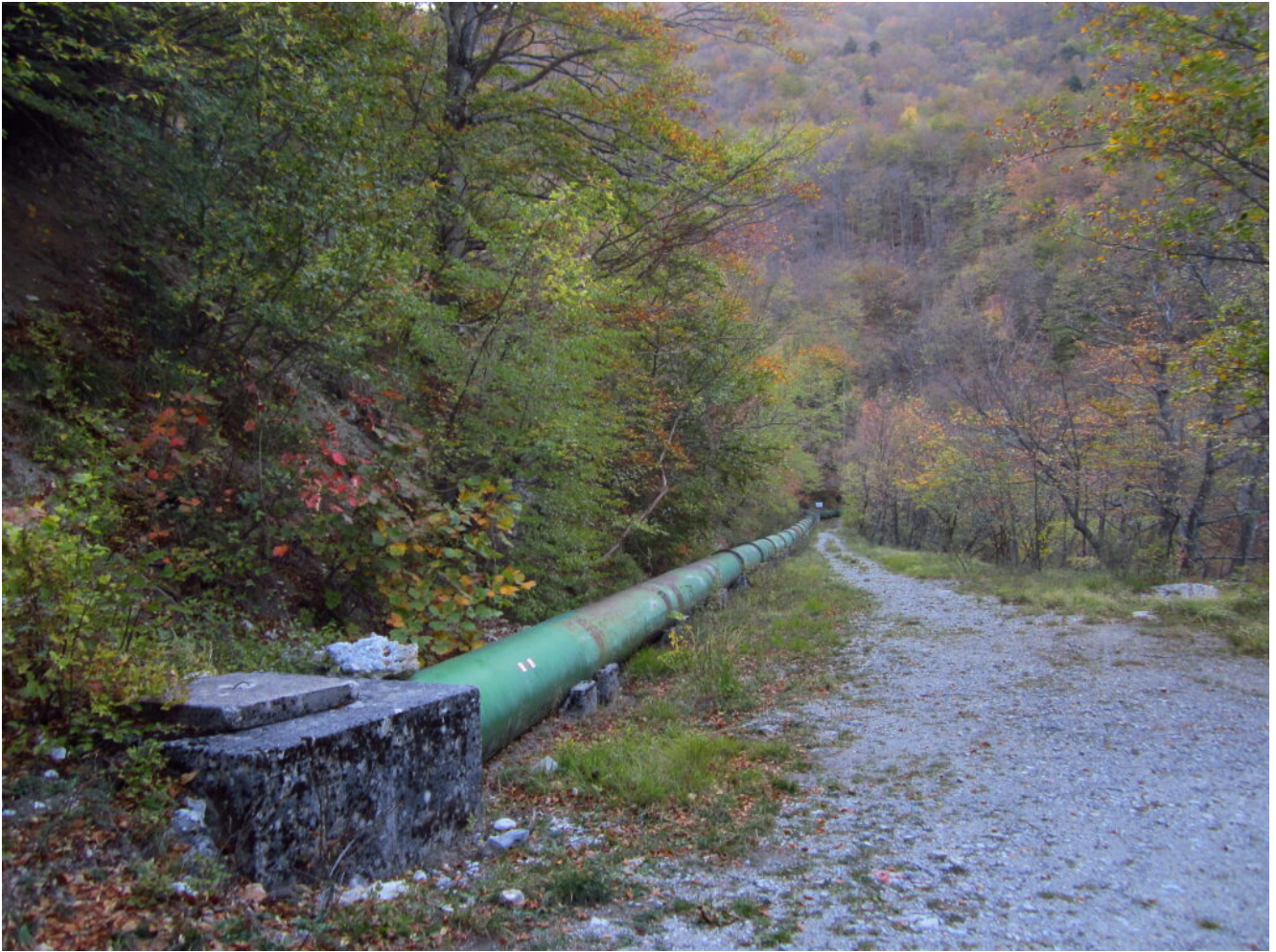
5- Il tratto con il canale metallico
